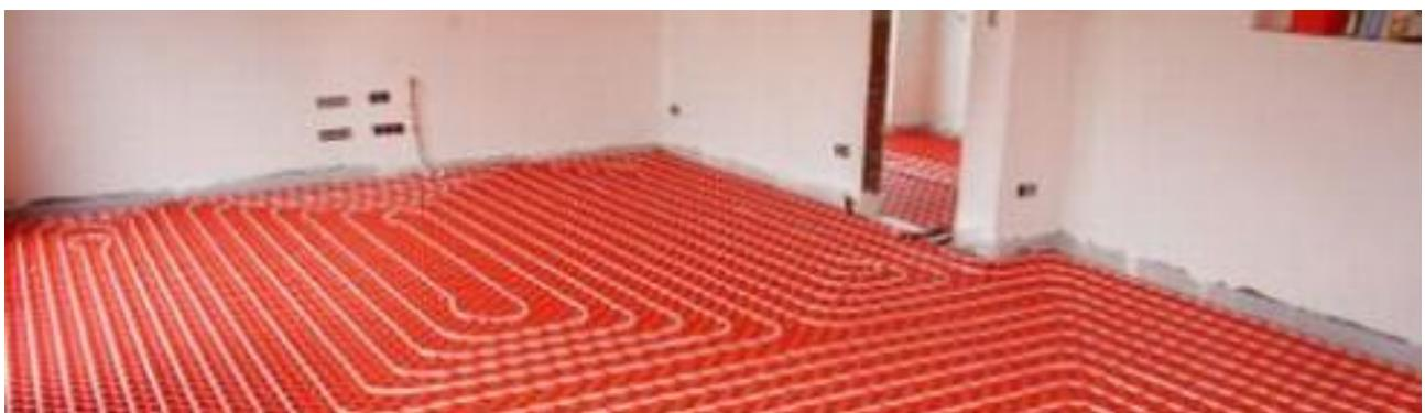
Il riscaldamento sarà realizzato con pannelli radianti a pavimento, con controllo delle temperature delle singole zone con opportuni termostati collocati nei singoli ambienti.
